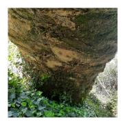
Ces arches sont d'ailleurs en mauvais état et vont nécessiter la réfection de l'enduit de la rigole sur toute la longueur de l'ouvrage. Leur porosité actuelle fait la joie des cannes de Camargue ou de Montpellier qui en ont envahi le pied et qui peuvent atteindre jusqu'à 8 mètres de haut.
