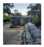
Ce petit édifice marque la fin du parcours de la rigole au niveau du sol sur 4840 mètres depuis la source. Les 1982 derniers mètres jusqu'au château seront nettement plus aériens. Nous appelons ce 25° et dernier décanteur, le filtre, car il est le dernier édifice à retenir les sédiments en suspension et les débris flottant sur l'eau.
