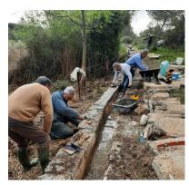
Si l'aqueduc zigzague horizontalement le long de la courbe de niveau 75, il ondule également verticalement suite à des affaissements de terrain ou d'ouvrage d'art, ce qui entraîne des contre-pentes et des fissures dans la maçonnerie nécessitant le rejointoiement voire le rehaussement des parois pour éviter les fuites et les débordements en cas de fort débit.
