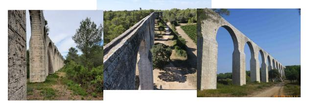
Entre le filtre et la rue des arceaux, la rigole parcours 1400 m perchée sur 103 arceaux d'un seul tenant!
