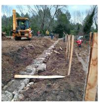
A noter qu'à partir de l'endroit où l'aqueduc revient en surface, au milieu de la prairie, il a été récemment récuré et clôturé pour éviter d'être défoncé par le bétail.
