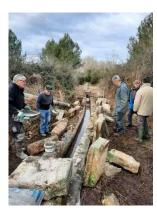
Ce second pont-aqueduc, enjambe un ruisseau et un chemin communal. Il a rapidement montré des faiblesses qui ont nécessité le moisage métallique de la douelle de la 2<sup>e</sup> arche au dessus du chemin et de construire, sous les 4 suivantes, des murs de soutènement qui ne remplissent plus guère leur office...
