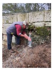
La rigole fait en moyenne 30 cm de large sur 45 cm de profondeur. Le débroussaillage de la rampe d'accès à l'aqueduc vers l'aval a mis en évidence de grosses fuites qui ont nécessité des travaux de colmatage et la remise en état du 5° décanteur depuis la source.
